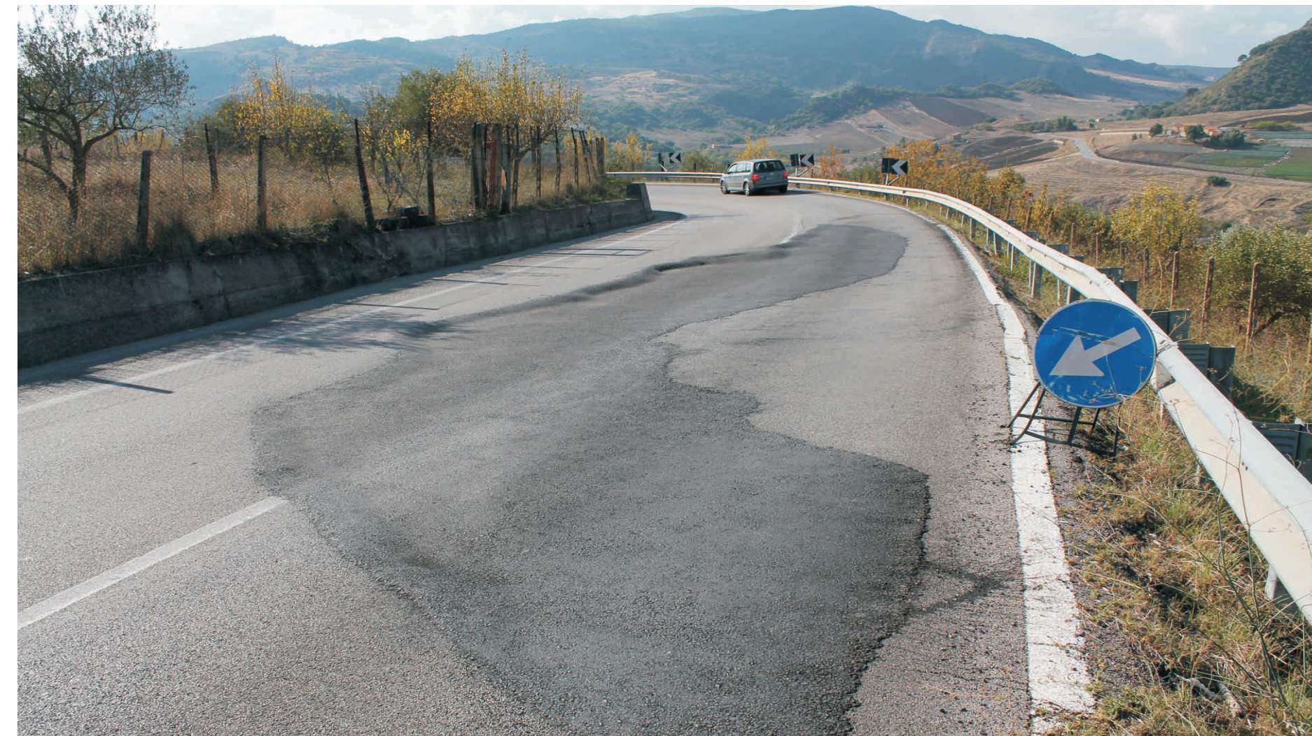
S.S. 117 Nicosia - Bivio Leonforte Villadoro
